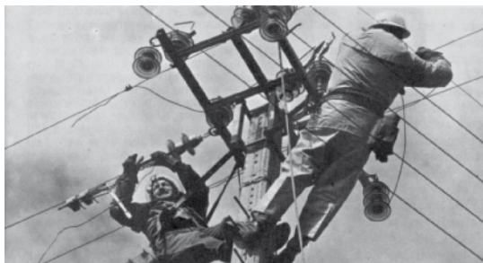
Intervention en aérien sur le réseau électrique, en 1965.
