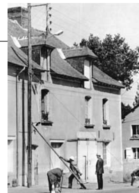
Installation d'un poteau électrique en bois, en 1967.
