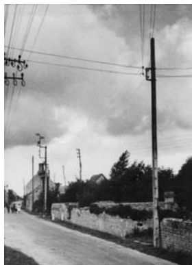
Réparations sur le réseau de moyenne tension en 1944, en Normandie.
